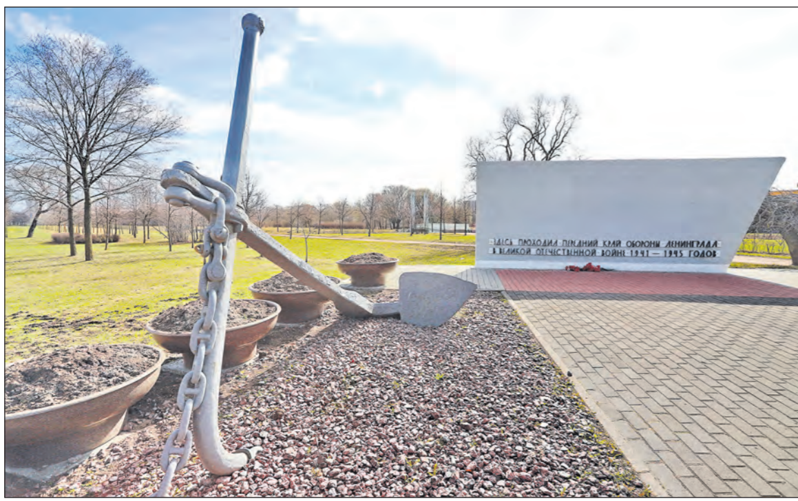
Памятник «Якорь» на Петергофском шоссе — часть мемориального комплекса «Кировский вал» в составе «Зеленого пояса Славы».
