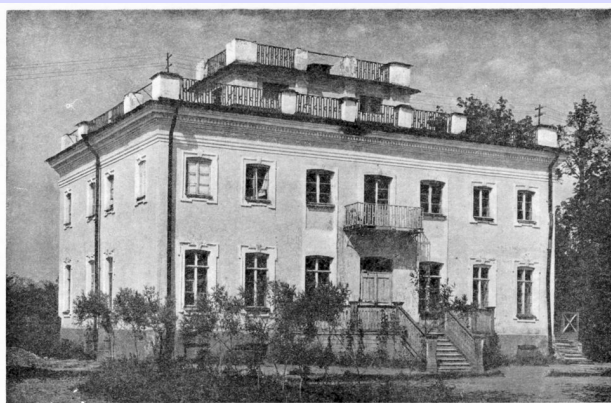
Дача А. Г. Демидова на Петергофской дороге. Фасад со стороны парадного двора. 1769—1770
